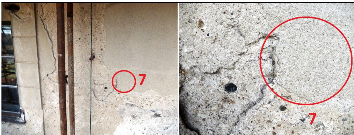
obr. 10 a obr. 11 Odběrové místo vzorku 7 (vlevo celkový pohled, vpravo detail)
